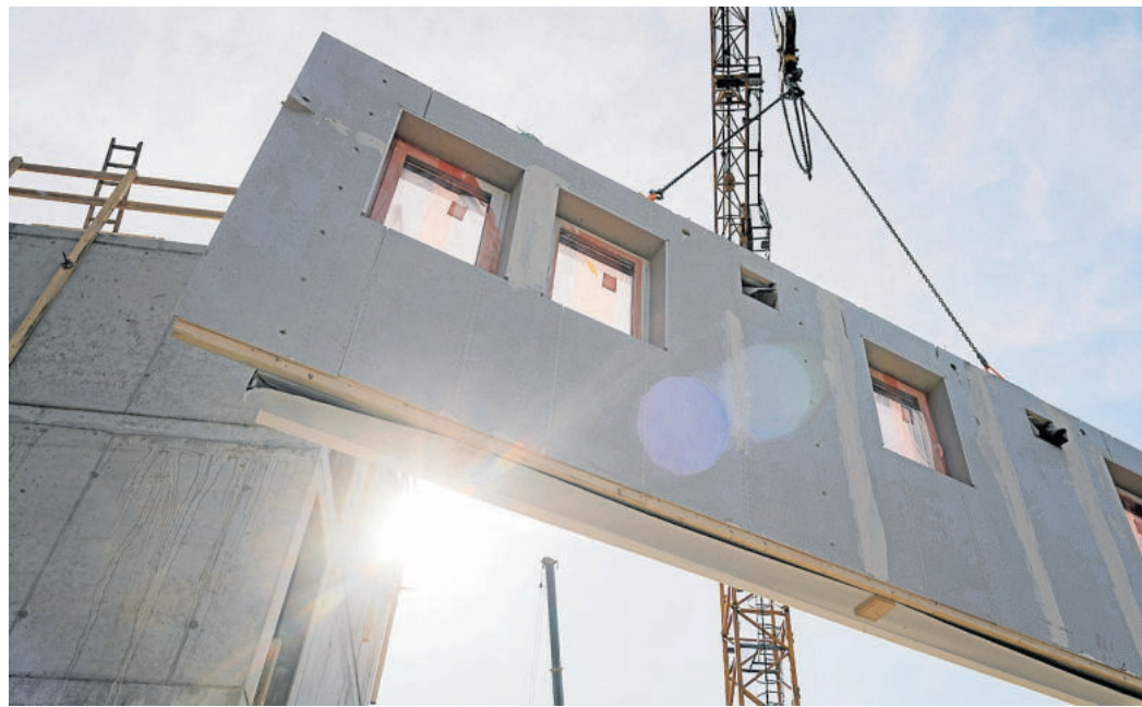
Das serielle Bauen mit Holz-Fertigteilen bietet viele Vorteile, darunter Schnelligkeit und Flexibilität.
