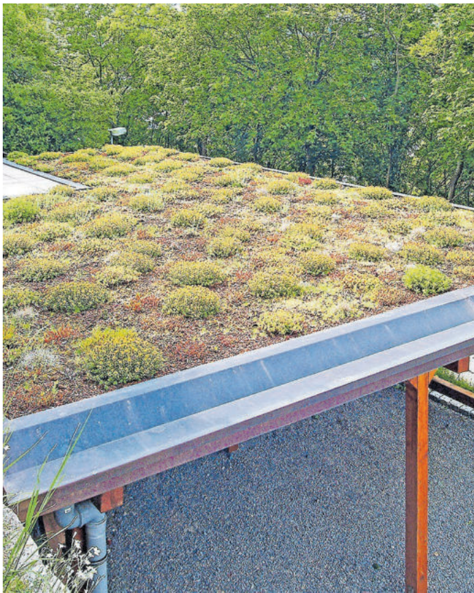
Kleine Dachfläche, große Wirkung: Begrünungen von Carport, Garage oder Gartenhäuschen verbessern das urbane Mikroklima. Foto: djdl/Paul Bauder
